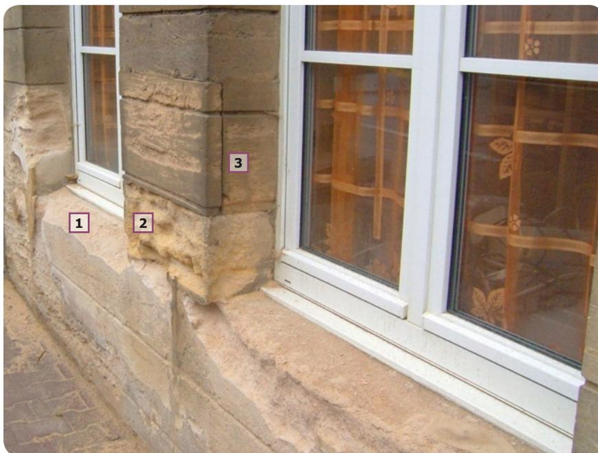
Cas d'une façade aux pierres d'appui **1** et jambages **2** altérés par des remontées capillaires et projection de sels de déneigement. Présence d'une restauration antérieure mal conduite **3** par placage d'une pierre d'épaisseur sous dimensionnée ne respectant pas les joints.
