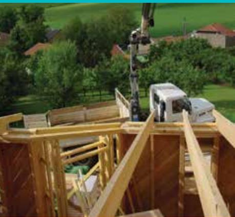
Pour une maison individuelle d'une surface de plancher de 120 m<sup>2</sup> réalisée en maçonnerie d'agglomérés et dans des conditions standards, la durée des travaux est d'environ 10 mois. Celle-ci sera ramenée à 8 mois pour une maison en ossature bois : la technique ne requiert pas de temps de séchage et se réalise pour partie en atelier, hors intempéries.
