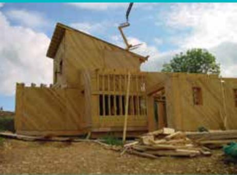
N'hésitez pas à réaliser un test d'étanchéité à l'air intermédiaire avant la pose des doublages, c'est une solution simple permettant de déceler rapidement les fuites résiduelles et d'y pallier. Les fuites d'air représentent 10 % des déperditions thermiques totales d'un bâtiment neuf.
