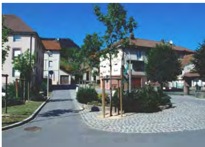
Dans la continuité de la rue St-Epvre, la place d'Oberthal est traitée de la même manière, sa nouvelle organisation facilite la circulation aux abords des écoles
