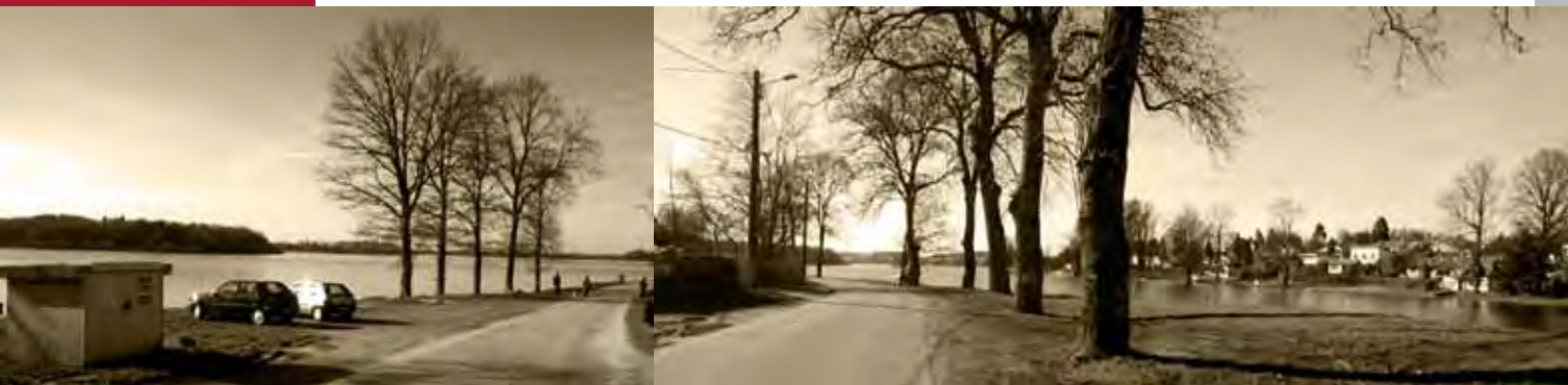
Les berges du lac avant travaux
