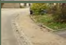
Sable stabilisé : groise calcaire côté ouest
