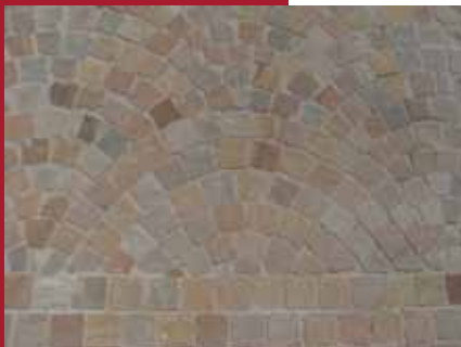
Détail de traitement du sol
