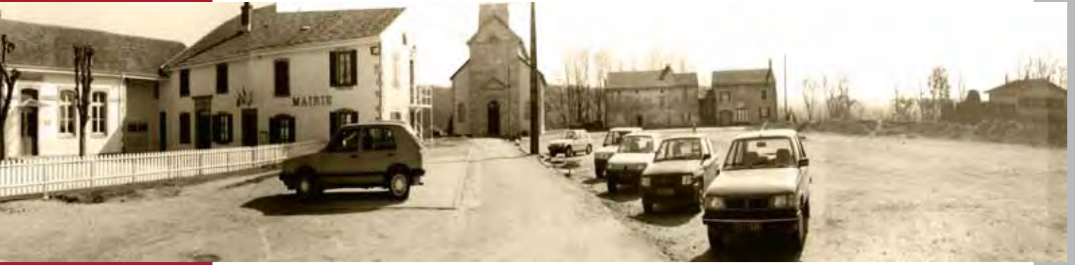
Etat avant travaux, photographie : E. Houillon
