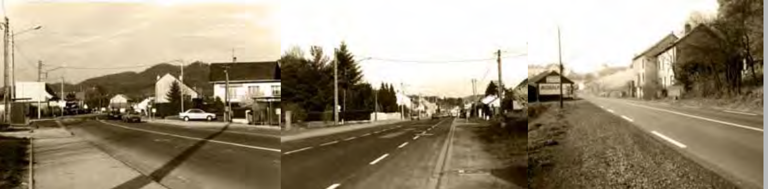
Les entrées d'agglomération est et ouest, avant travaux
