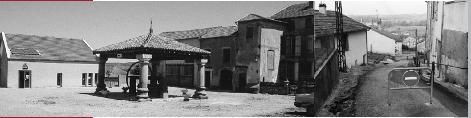
La place du Puits et la rue Alix Leclerc avant les travaux
