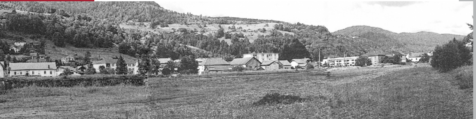
Le site avant les travaux
