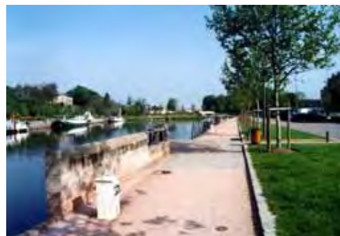
Pas japonais à suivre hors des sentiers battus... En arrière-plan, les arbres existants proches de la Moselle ont été conservés. Rappelant la végétation de bords de cours d'eau, des saules blancs ont été plantés le long du cheminement voisin
