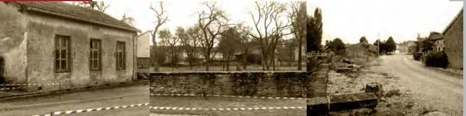
Le lavoir, la place et la ruelle avant travaux
