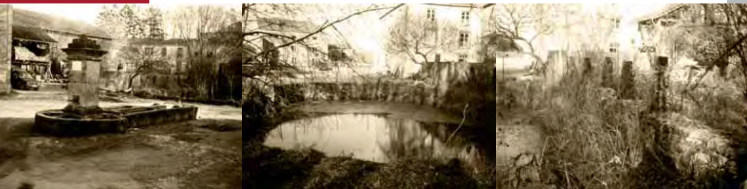
La place du Gué avant travaux
