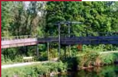
Côté Sauf-le-Cerf, le parc est accessible par une passerelle piétonne et cycliste, qui allie bois et métal
