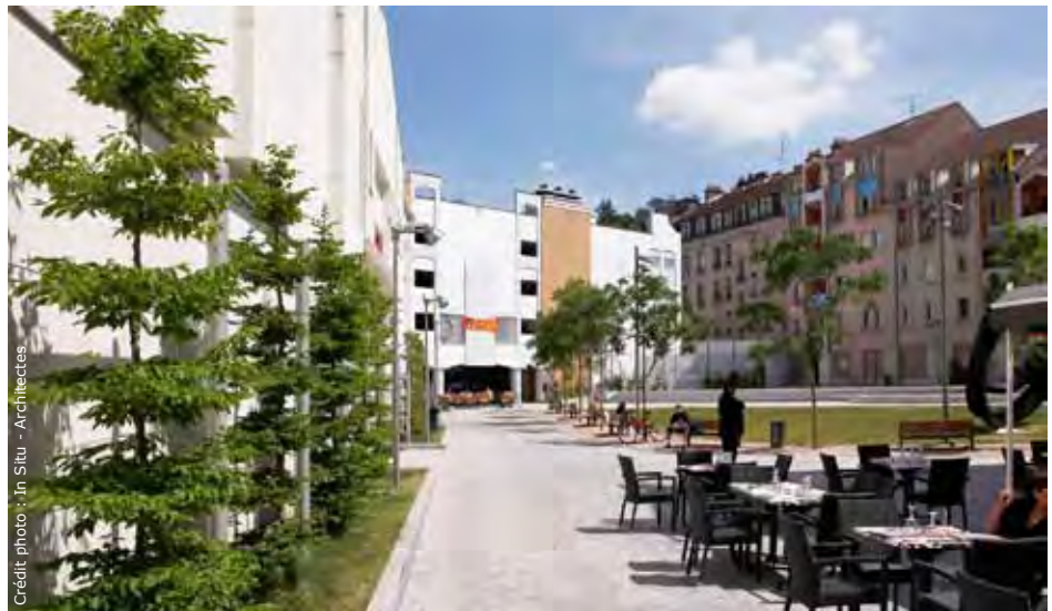
Aménagements réalisés place de la Chipotte
