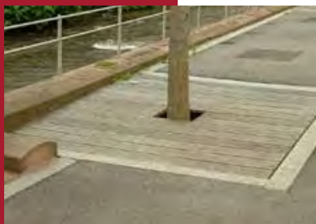
L'authenticité des matériaux est prise en compte : utilisation de grès identique à celui d'origine, de granit local et de bois
