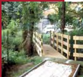
Une passerelle assure une liaison piétonne entre la ruelle du château et l'espace paysager à l'arrière du guéoir
