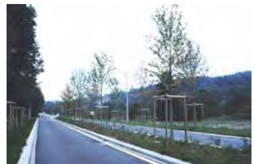
Côté Senones, l'entrée se structure à l'aide de deux alignements d'arbres latéraux et d'un terre-plein central, également planté, qui contraint fortement les automobilistes à ralentir.
