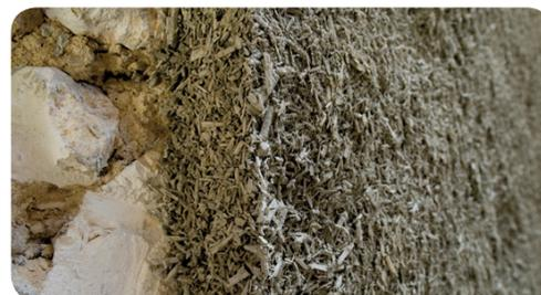
*Application d'un enduit isolant chaux-chanvre sur un mur intérieur en moellons*
