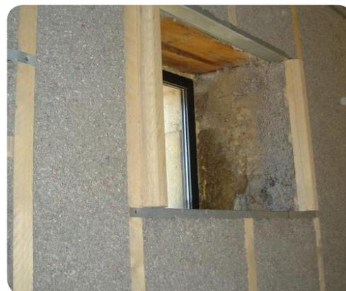
*Doublage isolant d'un mur en moellons avec un béton de chanvre*
