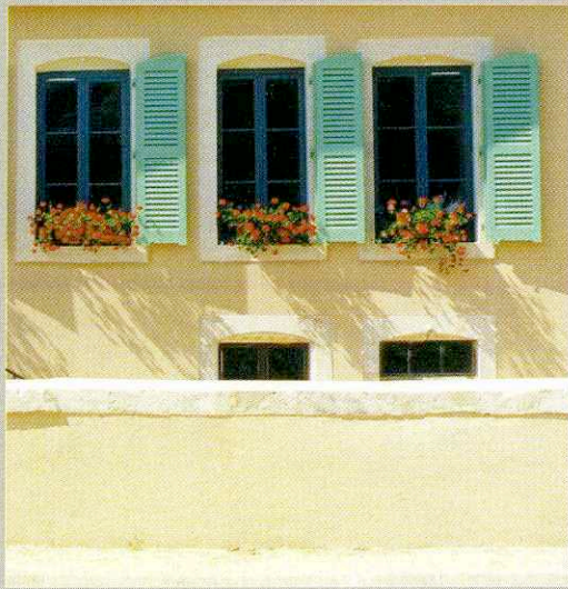
Exécution d'un enduit gratté avec le tranchant de la truelle.
