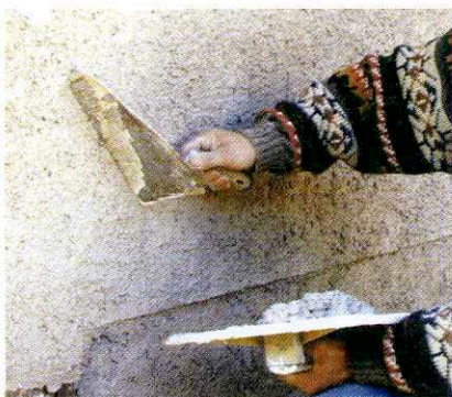
Test de finitions d'un enduit à la chaux sur un mur ancien.
