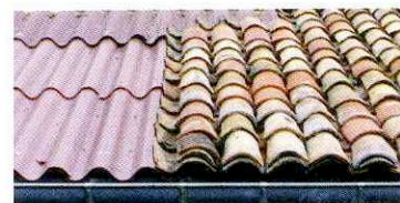
Panneaux de sous-toiture recouverts de tuiles canal
