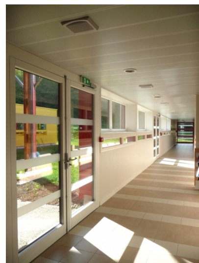
Les deux couloirs desservent les salles de classes et donnent accès à la cour arrière.
