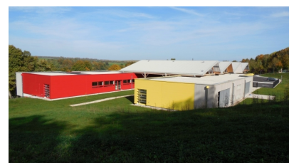
Partie arrière. Deux blocs distincts liés par un toit en sheds..
