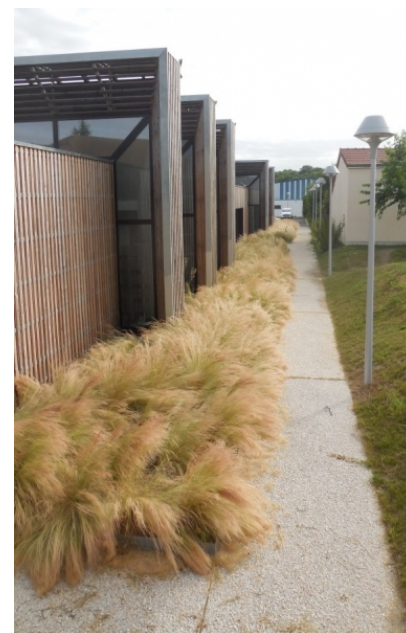
Les façades légères en bois se conjuguent bien avec les ondulations des graminées.
