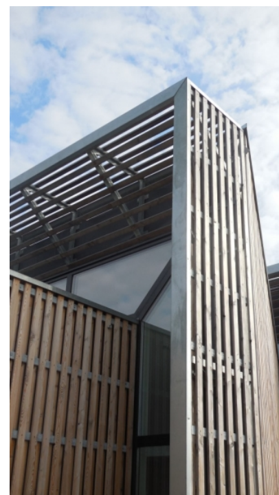
Des brise-soleil évitent les surchauffes tout au long de la journée.
