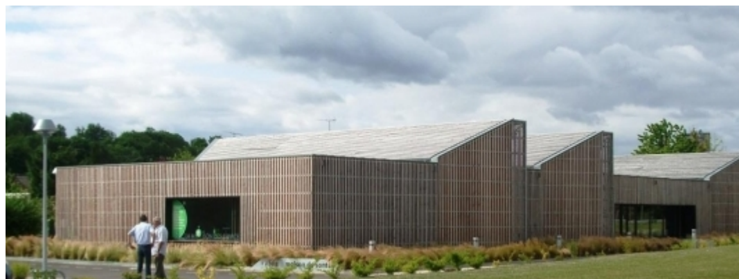
1 rue Simone Veil - Void-Vacon (1701 habitants)
